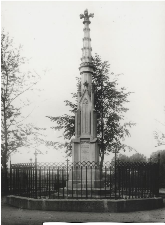
Engelbert-Kaempfer-Denkmal, ehemaliger Zustand
